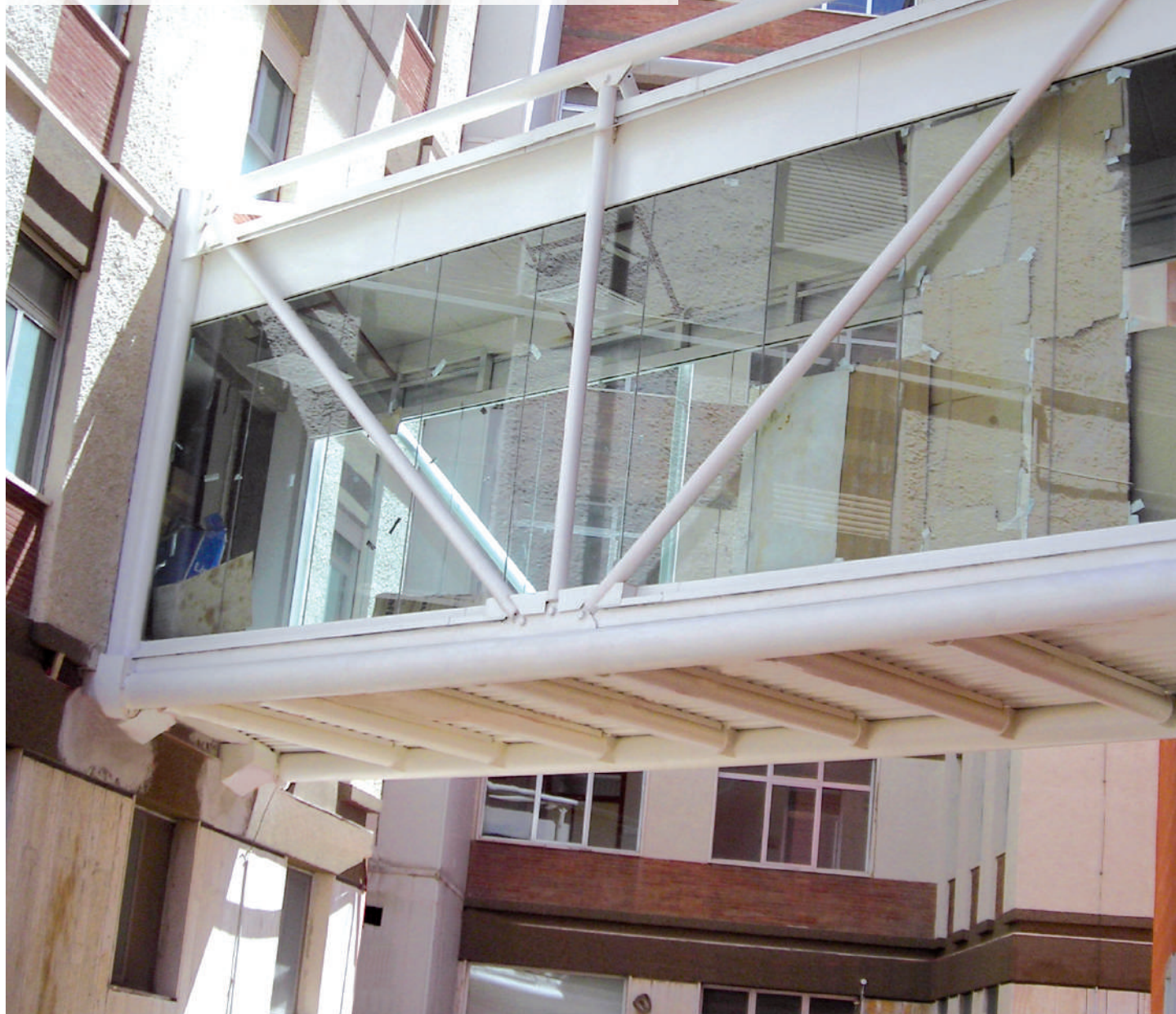
OSPEDALE SAN FILIPPO NERI (ROMA) Nuovo corpo "D" Passerella in carpenteria metallica di collegamento tra i due edifici, infissi a taglio termico
